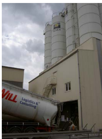
Figura 6.21 – Impianto di stoccaggio e miscelazione – Fonte ACEGAS APS
