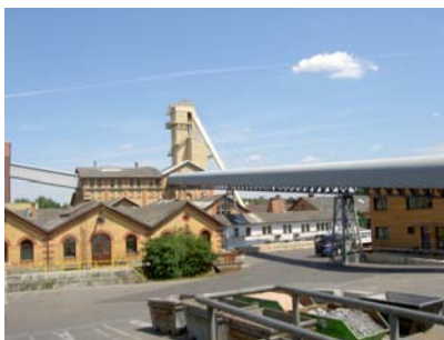
Figura 6.23 – Esterno dell'impianto e sistema di movimentazione polveri – Fonte ACEGAS APS
